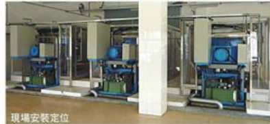
現場安裝定位
